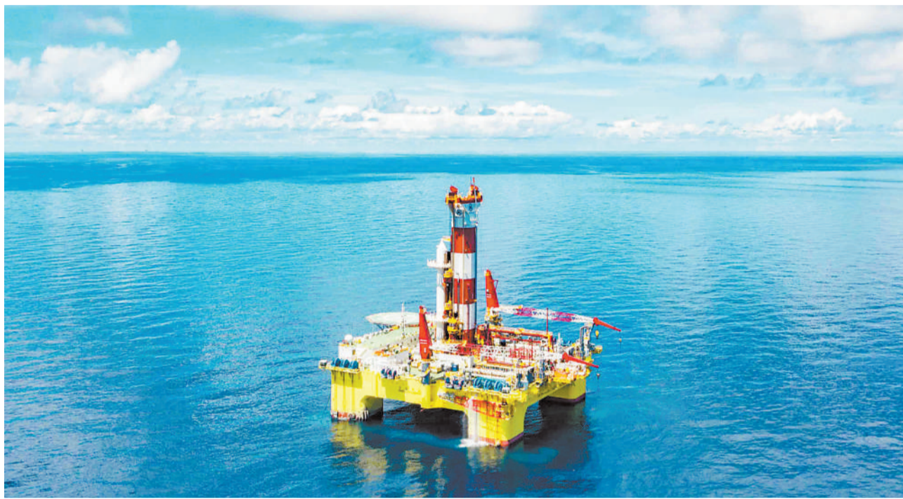
“深蓝探索”号钻井平台在开平南油田开展钻探作业。
