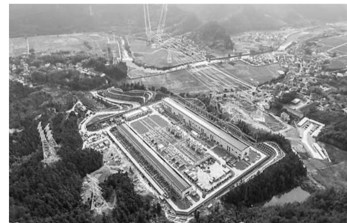
500千伏严州变电站俯瞰图。丁豪摄
