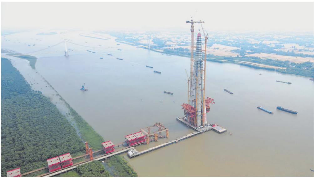
5月22日，由中铁大桥局承建的巢马城际铁路(巢湖至马鞍山)马鞍山长江公铁大桥4号墩主塔顺利封顶，该主塔为大桥中塔柱，塔高345米，是全桥最高主塔。至此，巢马城际铁路马鞍山长江公铁大桥三座主塔全部实现封顶，即将全面进入钢梁悬臂架设阶段。马鞍山长江公铁大桥是巢马城际铁路全线控制性工程，全长9.8公里，设计为三塔钢桁斜拉桥。巢马城际铁路是国家“八纵八横”高铁网沪汉蓉快速通道合肥至上海间的重要组成部分，设计时速350公里。
