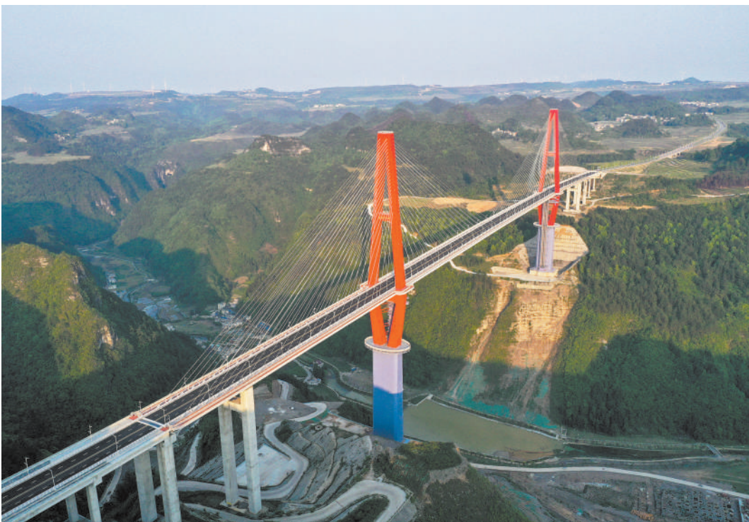
4月27日，由中交二公局承建的贵州龙里河大桥建设完工，实现通车。龙里河大桥位于贵州省龙里县境内，全长1260米，大桥主桥及塔柱设计有观光旅游玻璃栈道、全景观光电梯等旅游设施，是一座兼具旅游和交通功能的大桥。图为4月26日拍摄的贵州龙里河大桥(无人机照片)。新华社记者 杨文斌摄
