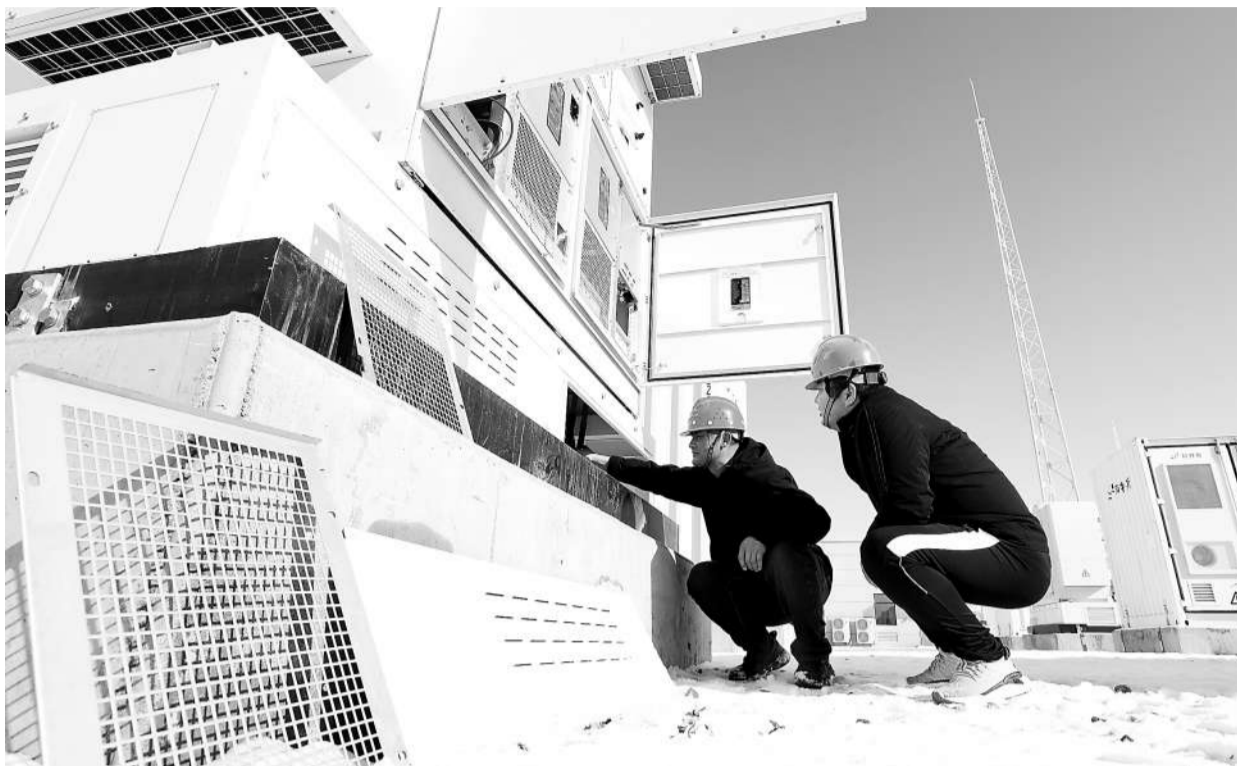
工人正在甘肃省张掖市民乐县工业园区丝路网能绿色能源500兆瓦/1000兆瓦时共享储能电站项目施工现场对储能仓进行检查。
