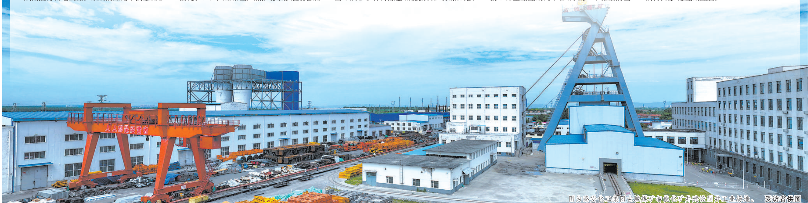
图为晋安化工集团古城煤矿智能化矿井建设副井工业场地。受访者供图
