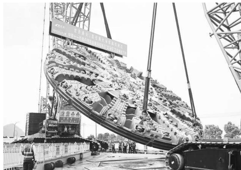
4月6日,由中铁十一局集团承建的甬舟铁路金塘海底隧道舟侧“定海号”盾构机核心部件组装完成,为甬舟铁路金塘海底隧道盾构机始发穿海奠基础。图为“定海号”盾构机刀盘在两台履带式起重机的协同配合下,从地面吊运至甬舟铁路金塘海底隧道舟侧盾构始发井(4月5日摄)。 新华社记者 黄宗治摄
