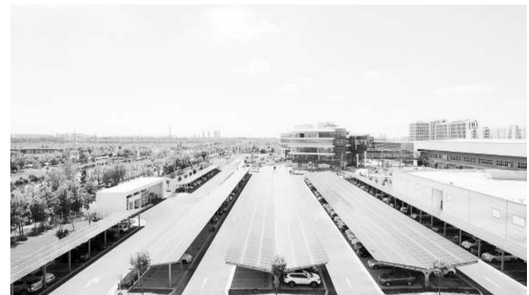
图为青岛高新区海克斯康智慧产业园车棚顶部光伏板。 受访者供图
