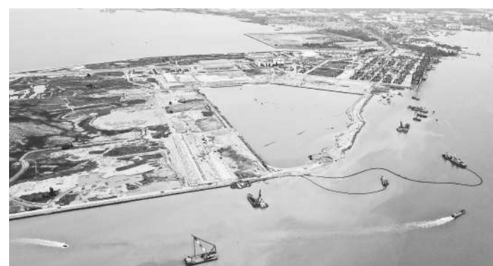
在推进自贸港封关运作的攻坚之年,海南省多个重大项目建设稳步推进。图为建设中的海南洋浦区域国际集装箱枢纽港扩建工程。 新华社记者 郭程摄
