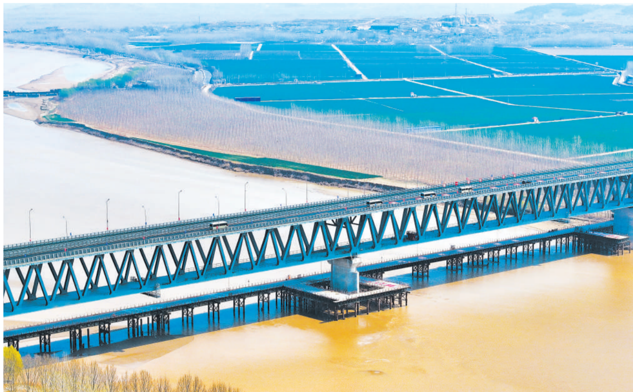
3月26日，建邦聊(城)泰(安)黄河公铁大桥正式通车。建邦聊泰黄河公铁大桥通车后，将进一步织密跨黄通道，促进黄河两岸互联互通、协同发展，加强省会经济圈各市的交通沟通联系，完善山东路网布局。图为车辆在在建邦聊(城)泰(安)黄河公铁大桥上(无人机照片)。
