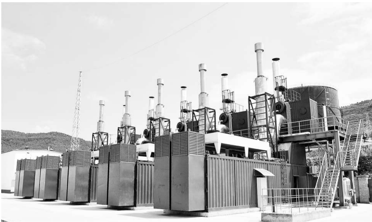
图为集装箱式瓦斯发电站。受访者供图
