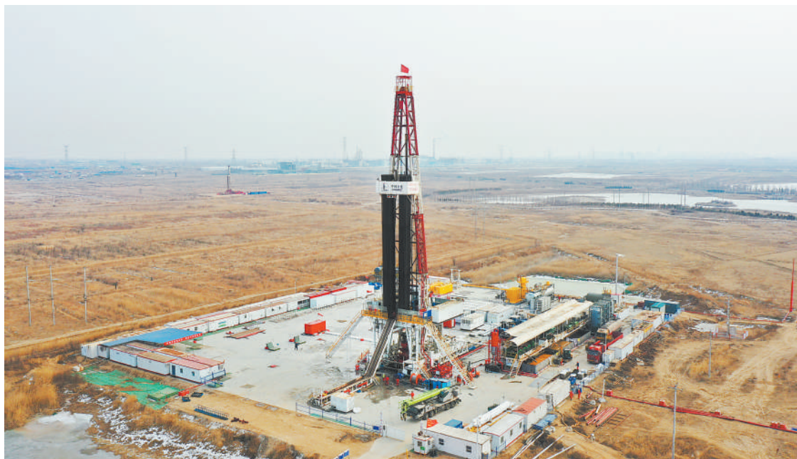
合成基钻井液施工现场。胜利工程公司供图
