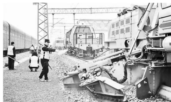
图为沈阳工务机械段大型养路机械正在对沈山线进行清筛作业。郝晓明摄
