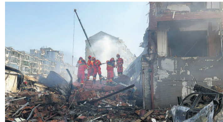
在河北省三河市燕郊镇爆燃事故现场,应急救援人员进行处置救援。 新华社发
