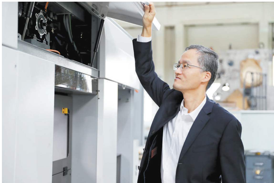
马立项在查看印钞设备安装情况。
