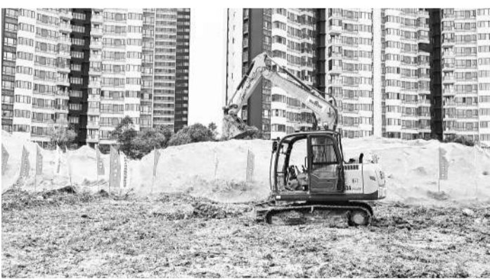
中建新疆建工联合百度研究院共同发布的面向建筑场景的无人挖掘机正在作业。 受访单位供图
