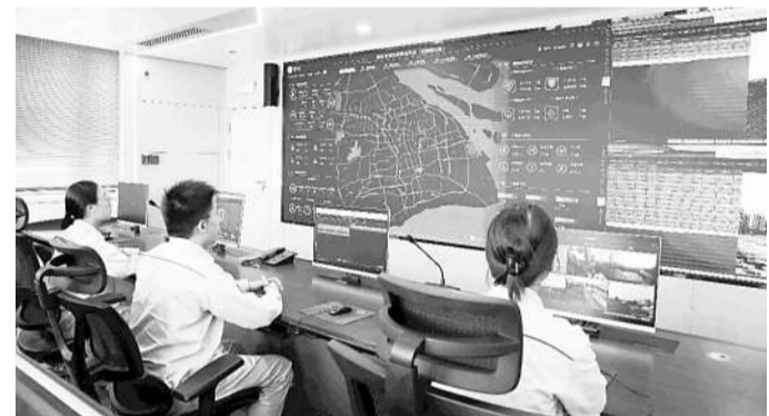
工作人员正在使用输电全景智慧管控平台对上海电网进行监测。受访者供图
