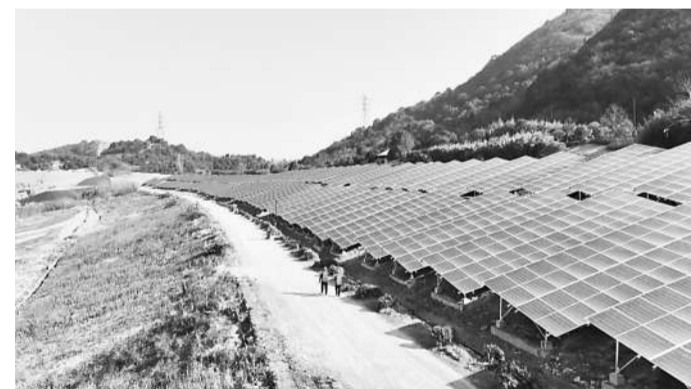
图为杭州天子岭垃圾填埋场光储一体化项目一期现场。姜家宝摄
