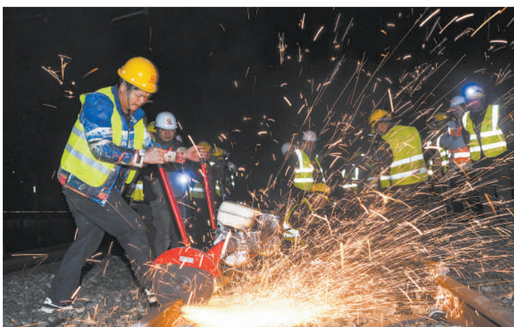
二月二日凌晨，工人在渝昆高铁渝昆段重庆西站一接轨点进行铺轨施工作业。新华社记者 王全超 摄
