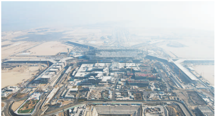
厦门翔安机场航站楼指廊主体结构近日全面封顶。中建三局供图
