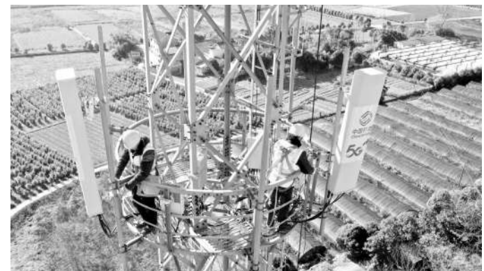
图为技术人员在对5G基站设备进行更新升级。截至2023年底,我国5G基站总数达337.7万个。
