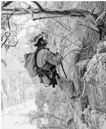
重庆市地质矿产研究院组织高空作业人员攀爬崖壁，安装地质灾害防治监测设备。
