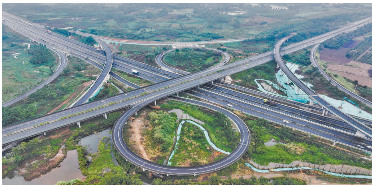
目前,中铁十一局承建的沈海国家高速茂港段改扩建工程临近收官。该项目位于雷州半岛,起于广东茂名市电白区,终于广东湛江市麻章区,全长约108.6公里。上图 近期建成通车的东坡岭枢纽位于湛江市遂溪县,是沈海和兰海两条国家高速公路的交汇点(无人机照片,1月23日摄)。
