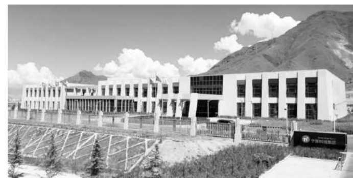
图为西藏存算一体化数据中心。
