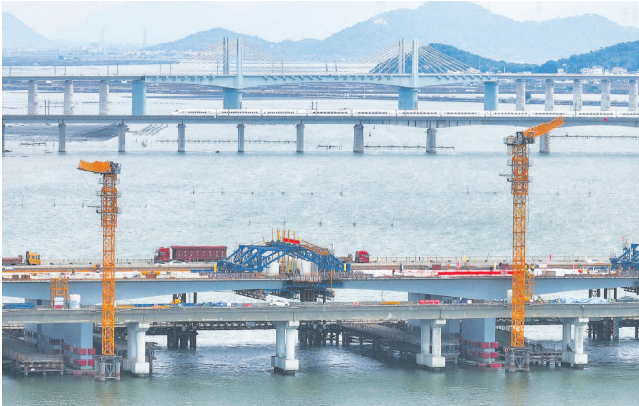
1月21日,中铁四局承建的深汕西高速改扩建项目长沙湾跨海特大桥左幅主跨合龙。作为沈海国家高速公路汕尾陆丰至深圳龙岗段的深汕西高速改扩建项目全长约146公里。长沙湾跨海特大桥是项目全线控制性工程,桥梁全长2108米,采用先新建右幅新桥,再拆除既有特大桥重建左幅的施工方式,大桥右幅已于2023年3月22日建成通车。图为1月21日拍摄的深汕西高速长沙湾跨海特大桥(无人机照片)。新华社记者 刘大伟摄
