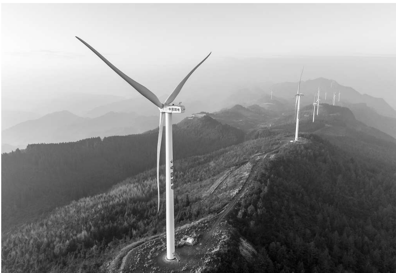
千野草场景区位于重庆市石柱土家族自治县，是黄水国家森林公园的一个重点景区。景区资源丰富，集山、林、草、石于一体。冬日的早晨，千野草场景区云雾缭绕，景色迷人。图为1月10日在千野草场景区拍摄的风力发电机组（无人机照片）。新华社记者 黄伟摄
