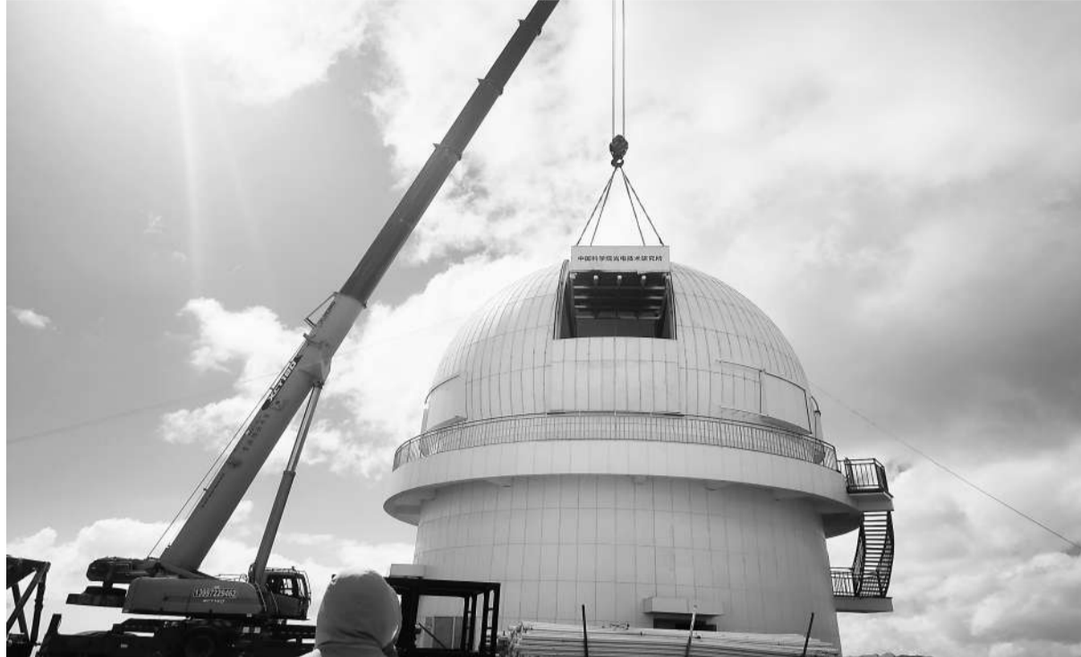
墨子巡天望远镜主镜部件吊装。冷湖科技创新产业园区管理委员会供图
