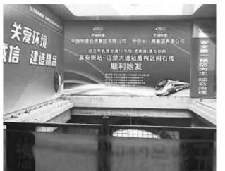
右线全长685.6米，由中国铁建投资集团有限公司参与投资建设管理、中铁十一局集团负责承建。区间左、右线间距9~14.2米，采用盾构法施工，两台盾构机先后于江楚大道站小里程端盾构始发，向富安街站方向掘进，于富安街站大里程端盾构并接收。
