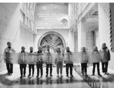
武汉地铁12号线茶—青区间双线顺利贯通。
