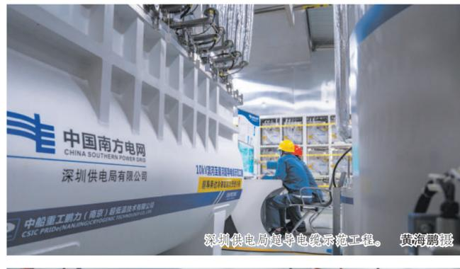
深圳供电局超导电缆示范工程。黄海鹏摄
