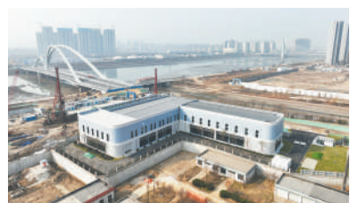
华能长输热力管线海洋活力区换热站。
