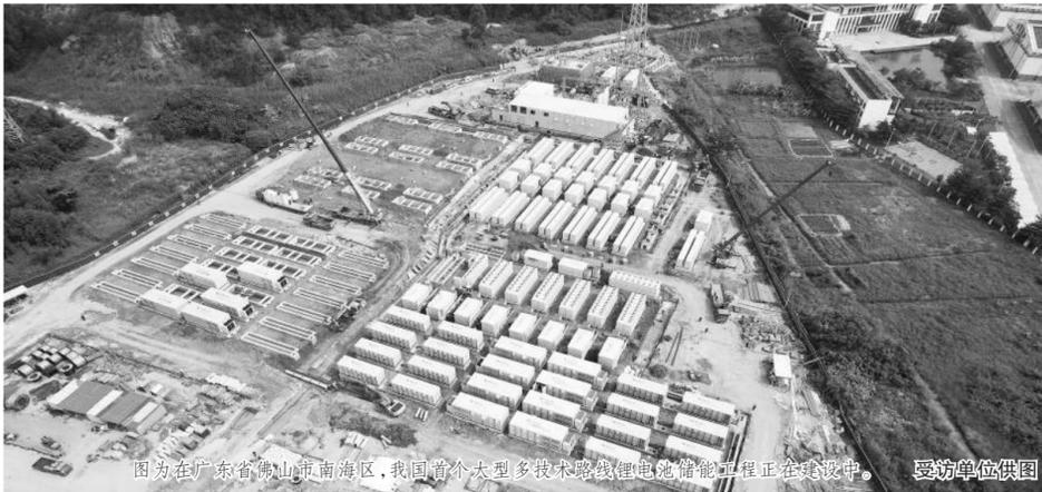
图为在广东省佛山市南海区,我国首个大型多技术路线锂电池储能工程正在建设中。受访单位供图
