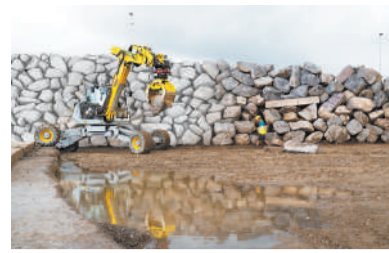
自主挖掘机正在建造石墙。 图片来源：《科学·机器人学》
