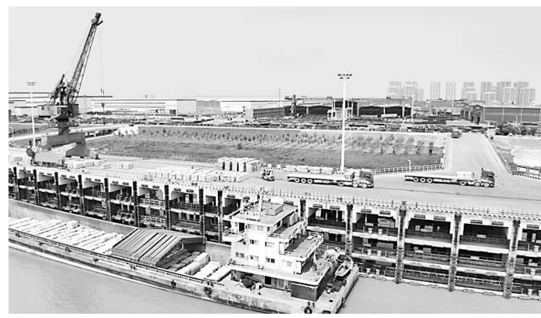
图为武汉阳逻产业园码头门座式起重机正在进行大理石装卸作业。王翰文摄
