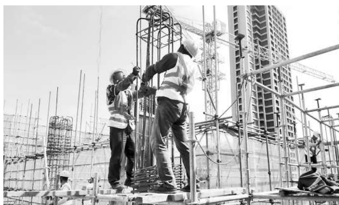
青岛高新区开展“快捷建”专项服务,推动项目早开工、快建设。图为项目建设现场。青岛高新区供图
