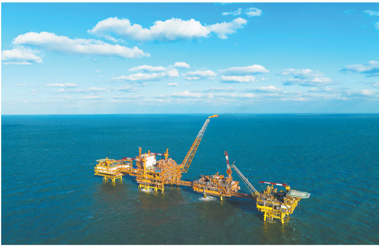
图为11月14日拍摄的渤中19-6气田(无人机照片)。
