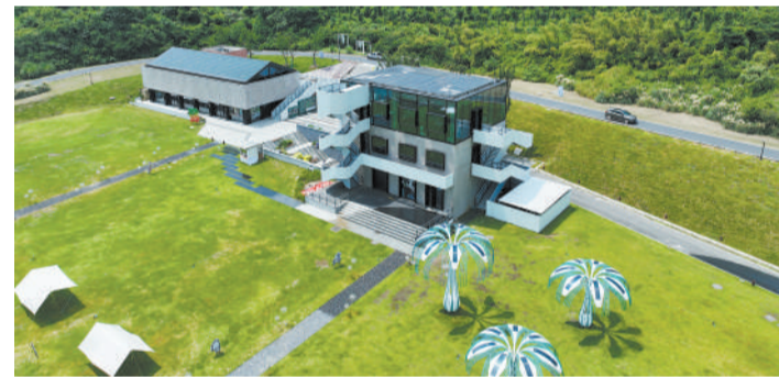
图为浙江省湖州市安吉县余村未来图书馆，其主要通过铺设在屋顶上的光伏发电系统和“光伏树”供电(无人机照片)。新华社记者 翁忻旸摄
