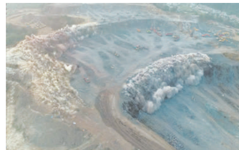
专业货运枢纽机场鄂州花湖机场土石方爆破工程。
