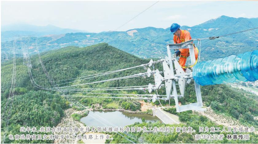
近年来,我国在特高压输电技术领域推动标准国际化工作达到了新高度。图为施工人员在福建北电南送特高压交流输电工程线路作业上作业。新华社记者 林善传摄
