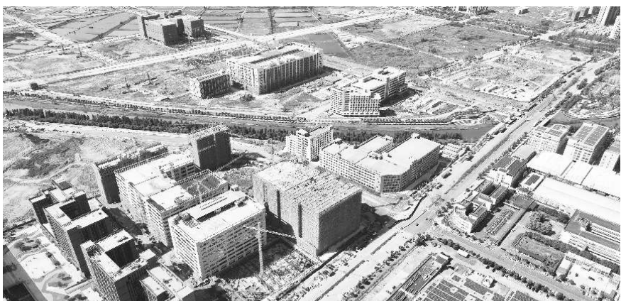
图为江门高新区内,建设中的江门市安全应急产业园。
