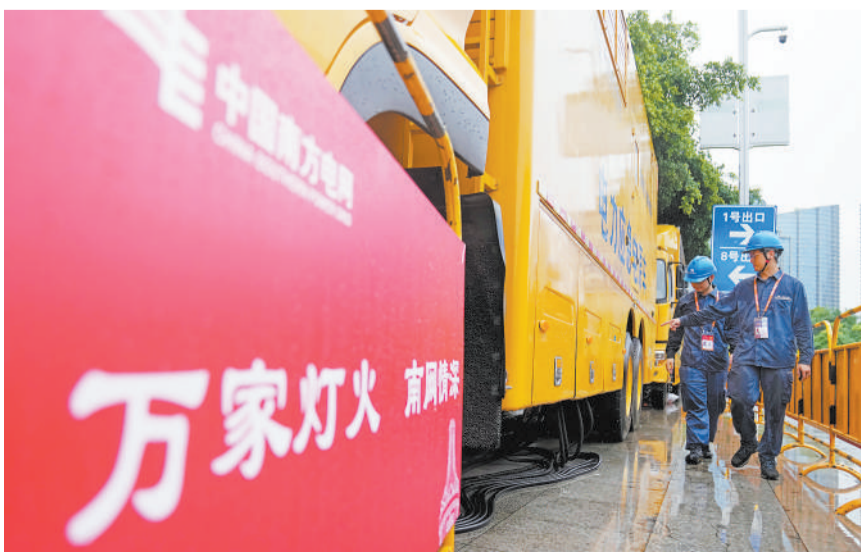
南方电网广西电网公司保电人员正在对供电设备进行巡视维护。
