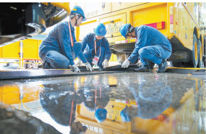
在南宁国际会展中心,南方电网广西电网公司保电人员检查电缆。
