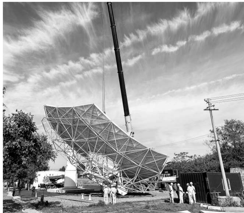
图为SKA项目首台中频天线吊装现场。 实习记者 林雨晨摄
