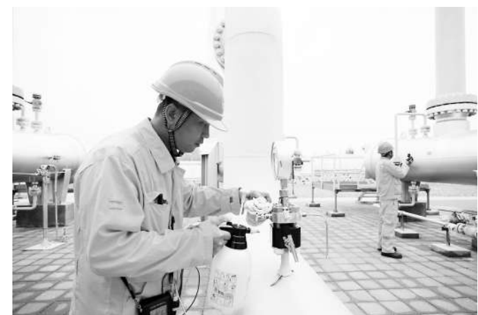
西气东输湖广输气分公司员工在广西支干线投产现场进行天然气泄漏检测。 国家管网集团供图
