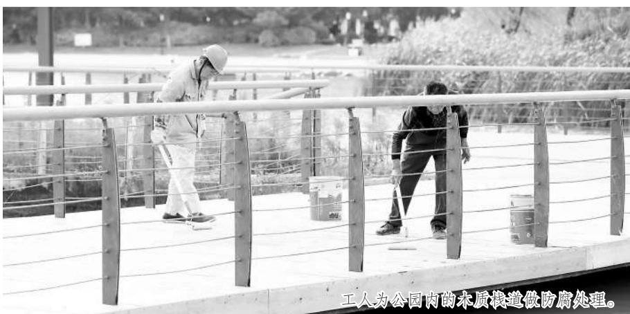
工人为公园内的木质栈道做防腐处理。
