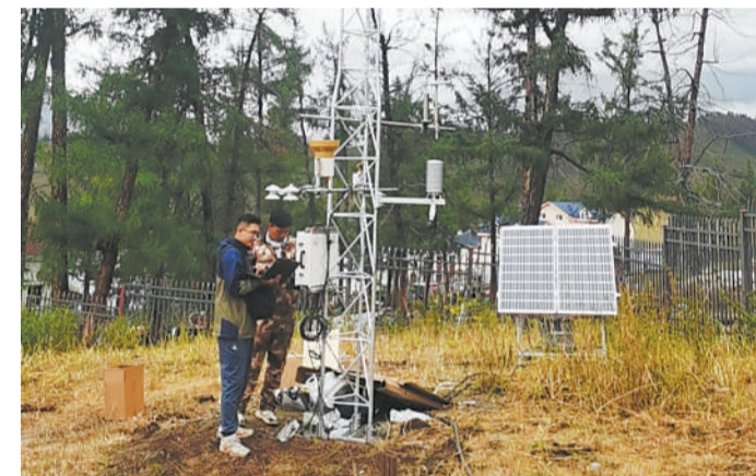
阿勒泰综合野外站工作人员正在安装调试观测设备。徐俊荣摄
