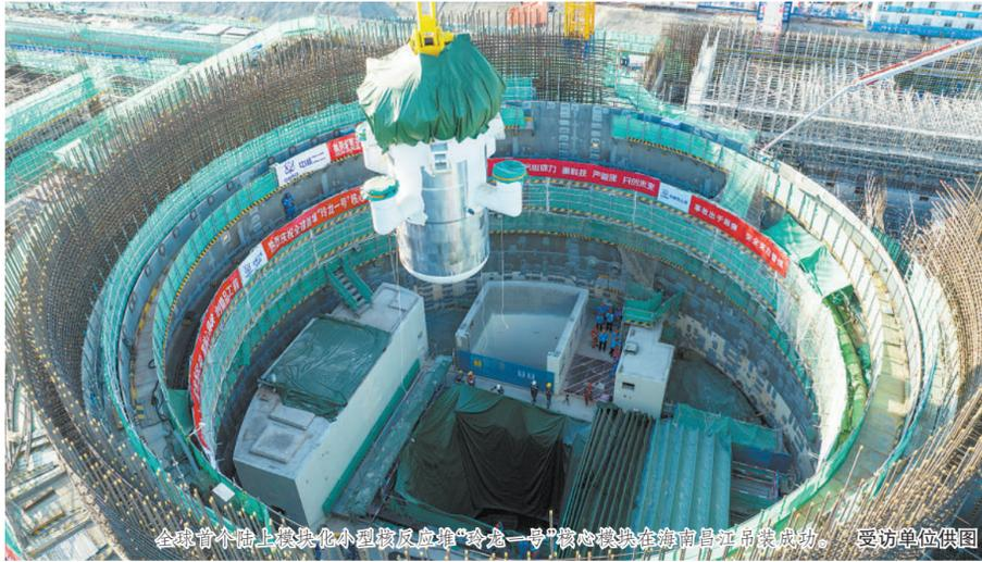
全球首个陆上模块化小型核反应堆“玲龙一号”核心模块在海南昌江吊装成功。受访单位供图
