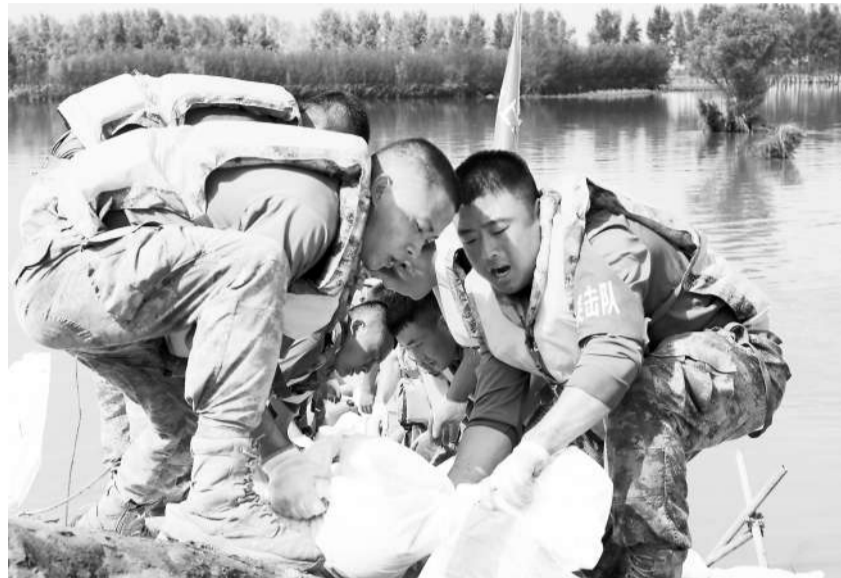
图为北部战区陆军某旅党员突击队成员在扶余市弓棚子镇拉林河杨家崴子段封堵决口(8月14日摄)。
