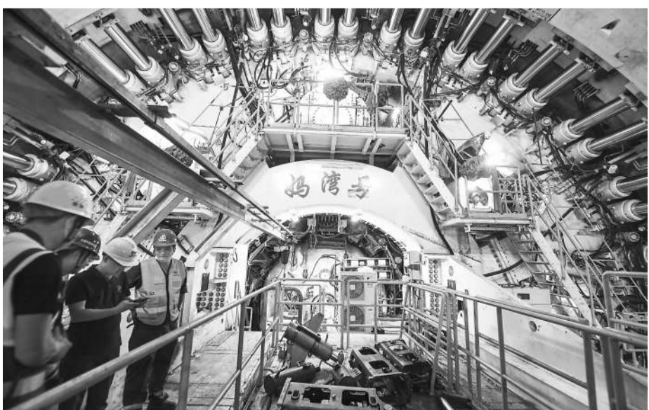
在深圳妈湾跨海通道工程建设现场，工作人员在“妈湾号”盾构机旁工作。 新华社记者 毛思倩摄
