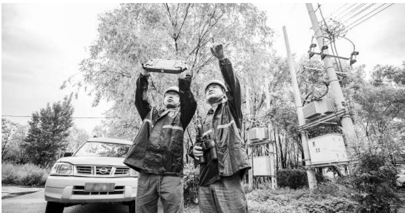
7月29日，北京市气象台发布暴雨红色预警。国网北京市电力公司动员11776名保障人员到岗到位，做好暴雨应对工作。图为国网北京昌平供电公司工作人员刘鑫宇、李学增在阳坊镇东贾市村对辖区10千伏东贾市线开展巡检工作。实习记者 吴叶凡 通讯员 朱春晖/文 刘小军/摄
