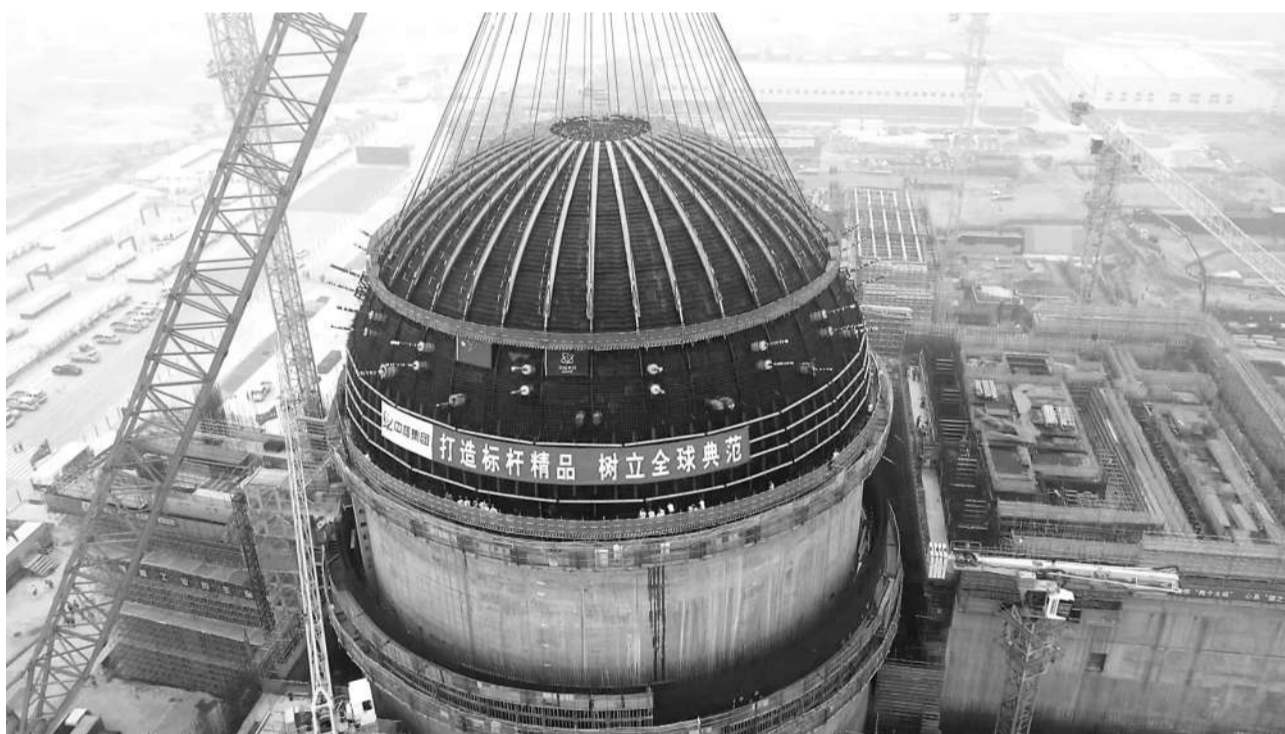
图为徐大堡核电项目3号机组穹顶吊装就位。
